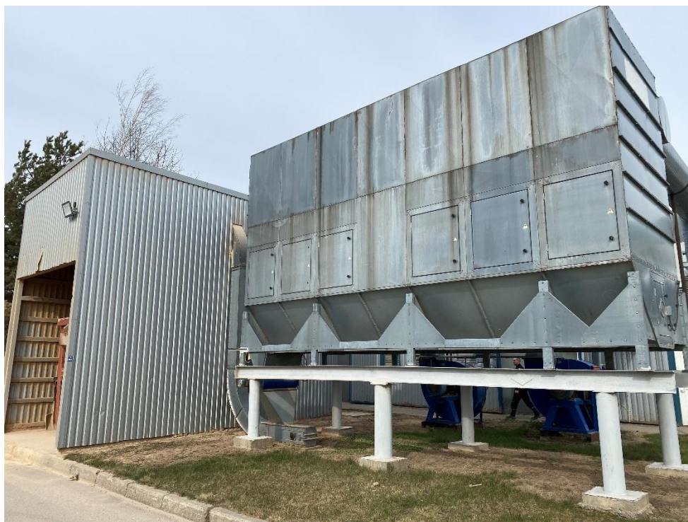
Paveikslas Nr. 2: Esama dulkių nutraukimo sistema, kurią reikia demontuoti (matmenys: aukštis 4600 mm, plotis 2460 mm, ilgis 7480 mm)
